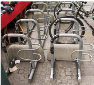
Tyto stojany jsme vyfotili v rakouském Linci. Jejich funkce je výborná, byť jsou po konstrukční stránce trochu složitější. Ochrana laku kola ale i tentokrát chybí, zamknutí za horní hlavovou trubku je bezproblémové.
