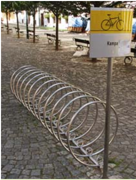
Klasické spirálové stojany, které se již před nějakou dobou objevily v centru Prahy, vypadají velice elegantně a jsou i celkem funkční. Nerezová ocel je navíc prakticky věčná. Jednou výraznější nevýhodou je užší spodní úchyt pro přední plášť, s nímž mohou mít bikeři s širším obutím trochu problém. Díky dostatečné výšce je možné kolo zamknout za rám, jakákoli ochrana proti oděnění laku ale bohužel chybí.
